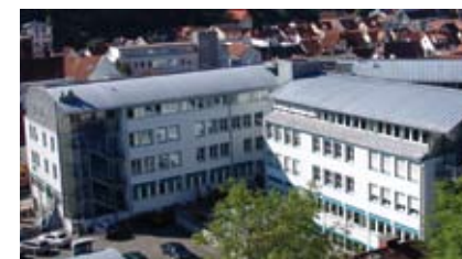
BA Heidenheim: Das Hauptgebäude
