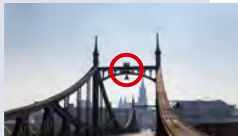
Fachwerkkonstruktion lagert auf zwei Pfeilern und überspannt drei Öffnungen. Die über den Pfeilern stehenden eisernen Pylone sind mit einem durchbrochenen, unten gerundeten Querriegel zu einem Portal verbunden. An den mit einer vergoldeten Krone versehenen Scheiteln der Bögen ist das Ulmer Wappen angebracht. Die oberen Enden der Pylone sind mit neugotischen Türmchen und vergoldeten Spitzen versehen. **Quelle: wikipedia.org**
