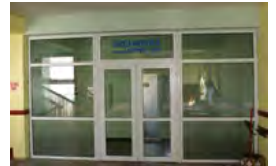
Chirurgische Station im KH Orsova nach Sanierung mit Spenden aus Ulm
