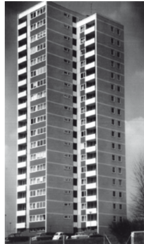
Damals: Nach der Fertigstellung 1966
