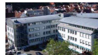
BA Heidenheim: Das Hauptgebäude
